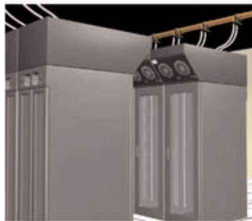
Abbildung 14. Die Ablaufkühlung ermöglicht die Realisierung höherer Rack-Dichten und die Optimierung der Kühlung.
