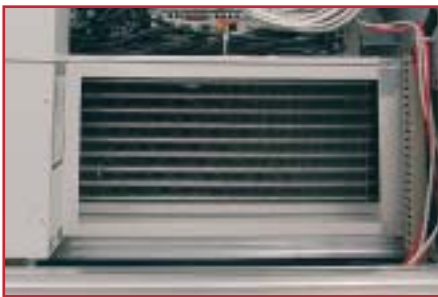
Knürr-Wärmetauscher, Luft/Wasser
