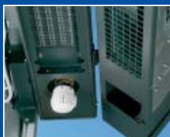
Tête thermostatique avec élément à dilatation de cire (sans groupe auxiliaire d'énergie)
